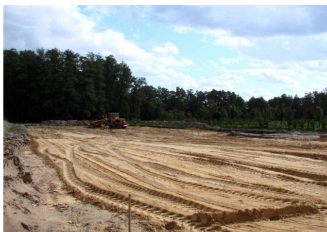
Terren pod budowę boiska
