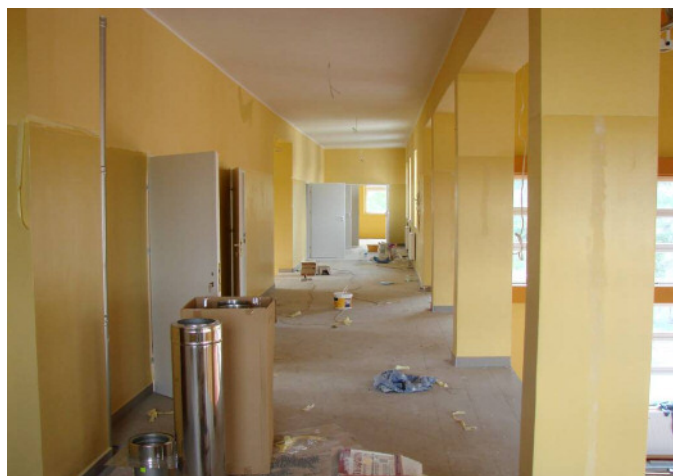
w trakcie prac wykończeniowych...
