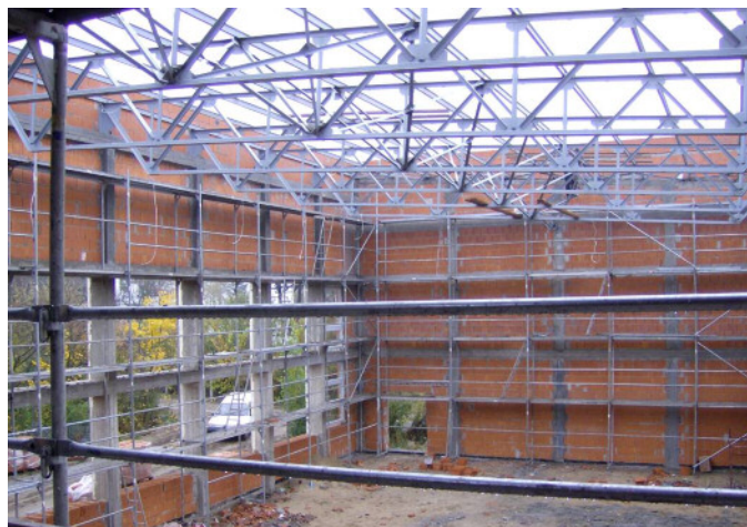
w trakcie budowy...
